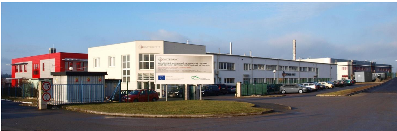
Obr.1 Celkový pohled na Západočeské materiálově metalurgické centrum v Dobrušce
